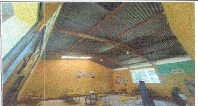
Foto 5: Módulo 1: reparación de sistema eléctrico
