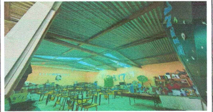
Foto 4: Módulo 2: sustitucion de soporte de madera por metal
