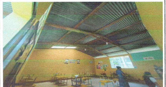
Foto 2: Módulo 1 sustitucion de soporte de madera a metal
