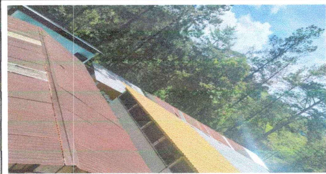
Foto 3: Módulo 2: Sustitución de lámina por lámina troquelada
